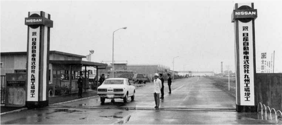
▲日産自動車九州工場 竣工式（1975年6月）の様子（日産自動車九州提供）
