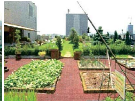
中央区:事務所ビル
