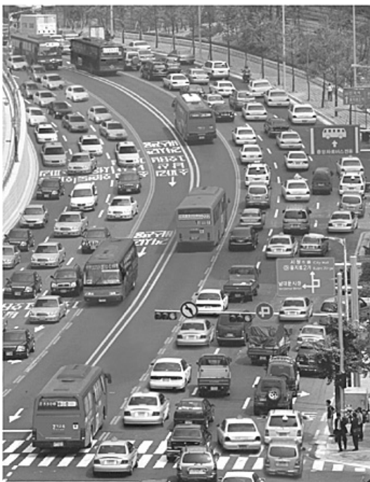
ソウルBRT 中央走行の様子
